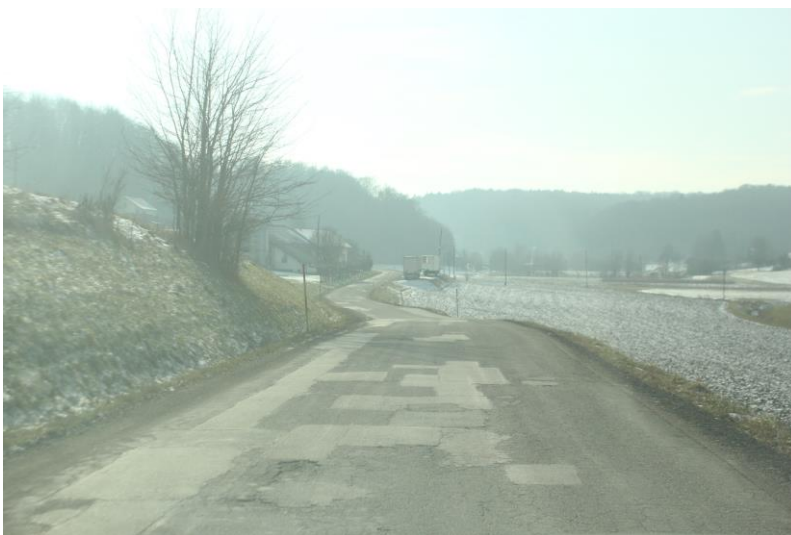
Pogled v območje P48-P55, vidne številne poškodbe in deformiran desni rob ceste, kjer se ob desni strani izvede kamnita peta, ob levem robu se izvede drenažno meteorna odvodnja.
