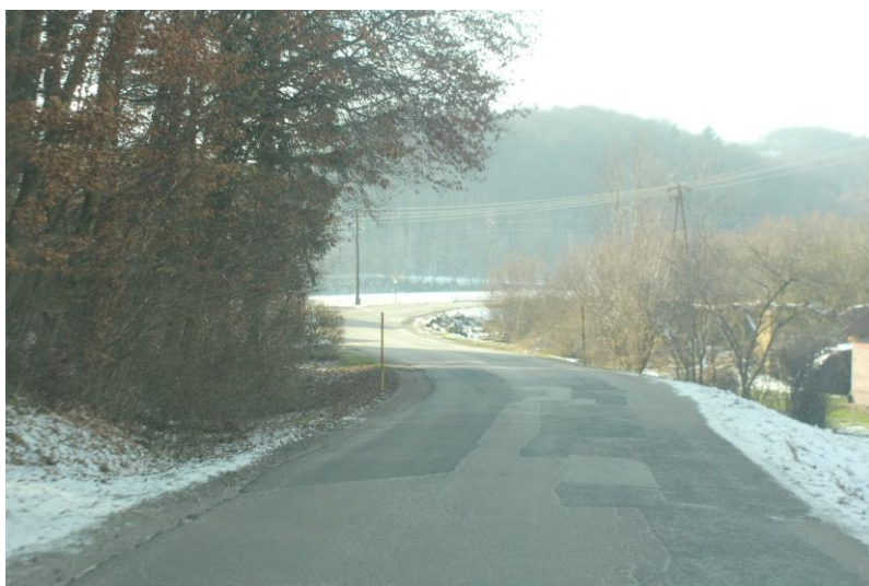
Pogled v območje P 79-P 84, kjer se ob desni strani izvede kamnita peta, ob levem robu se izvede drenažno meteorna odvodnja.
