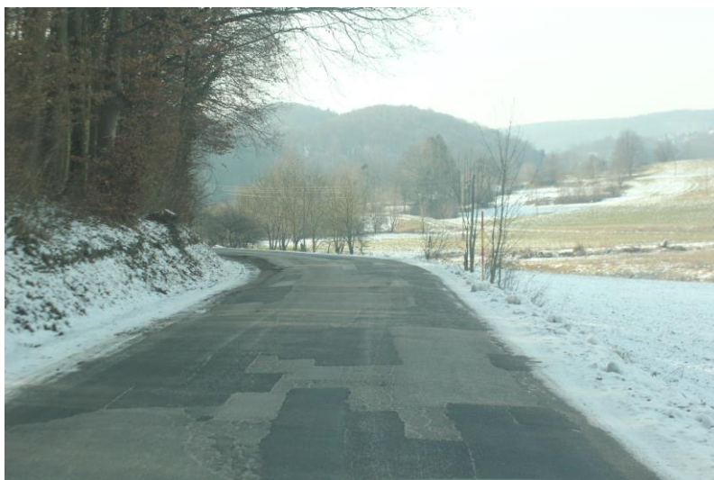
Pogled P73– P76, kjer se ob desni strani izvede kamnita peta, ob levem robu se izvede drenažno meteorna odvodnja.
