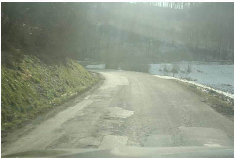
Pogled P66 – P71, kjer se se ob desni strani izvede kamnita peta, ob levem robu se izvede drenažno meteorna odvodnja.
