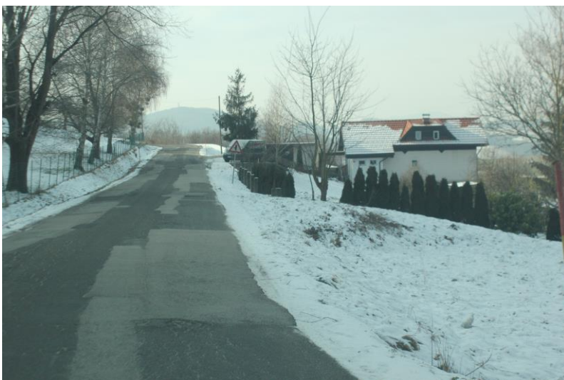
Pogled v območje P13-P12, pod Zavodom Hrastovec, kjer so vidne močne poškodbe, katere je občina večkrat poprpana, od konca zidu se izvede kamnita peta ob desne robu ceste, ob levem robu izvede drenažno meteorna kanalizacija.
