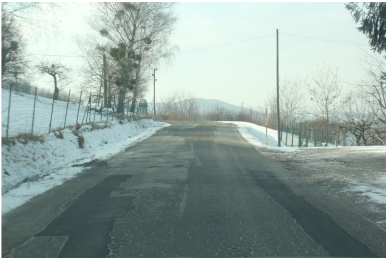
Pogled v območje P13-P12, pod Zavodom Hrastovec, kjer so vidne močne poškodbe, katere je občina večkrat pokrpana in izvede se kamnita peta ob desnem robu ceste, ob levem robu izvede drenažno meteorna kanalizacija
