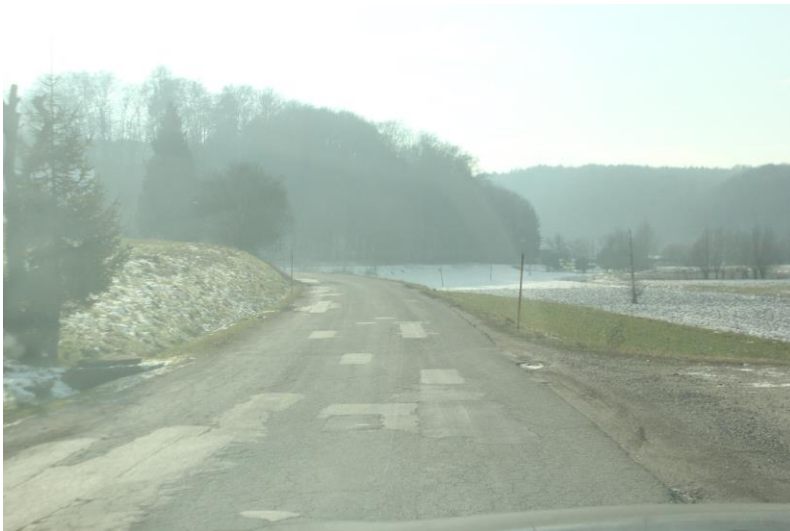
Pogled P58 - P64, kjer se se ob desni strani izvede kamnita peta, ob levem robu se izvede drenažno meteorna odvodnja.
