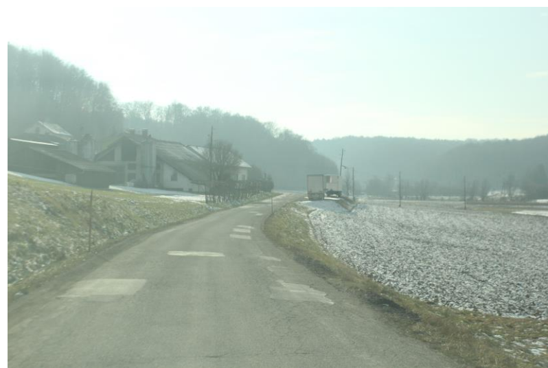
Pogled v območje P50-P58, vidne številne poškodbe in deformiran desni rob ceste, kjer se ob desni strani izvede kamnita peta, ob levem robu se izvede drenažno meteorna odvodnja.
